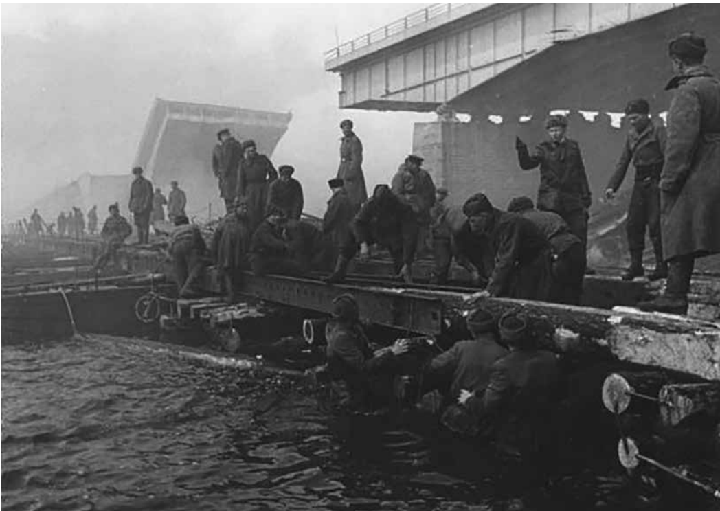
Raudonosios armijos kariai stato pontoninį tiltą per Oderį prie Štettino (dab. Ščecinas).
