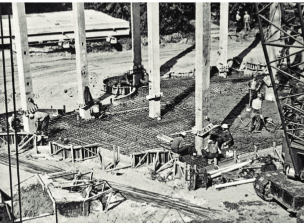
Fizioterapijos gydyklos statybos: perdangų liejimas ir pakėlimas. 1975 m. Fot. nežinomas LNM
